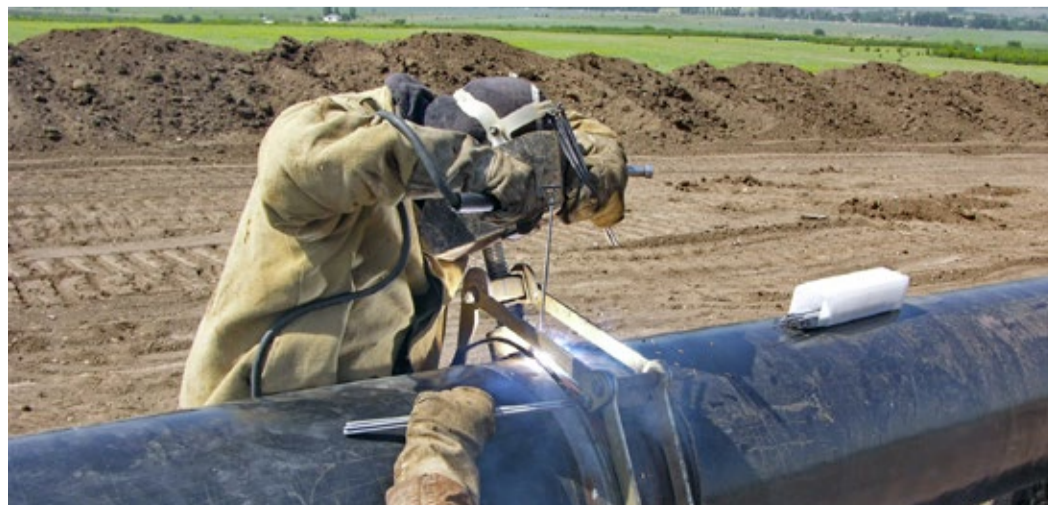
Сварка первого стыка ГО «Ботлих»
