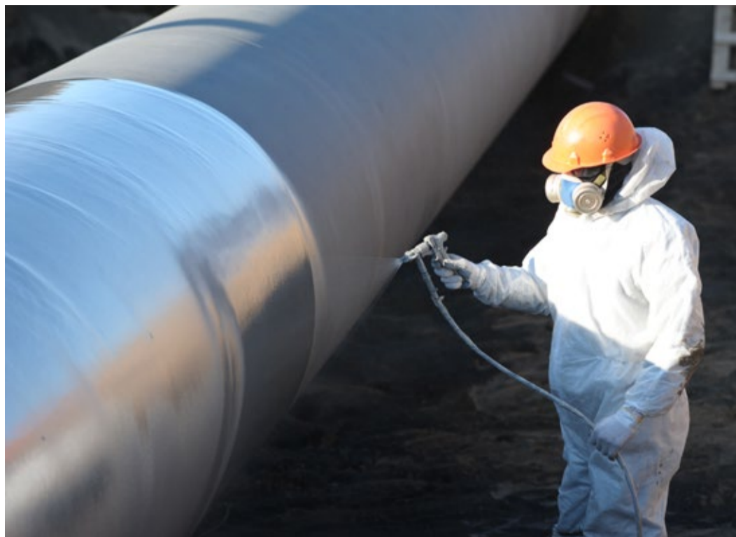
Нанесение полиуретанового покрытия
