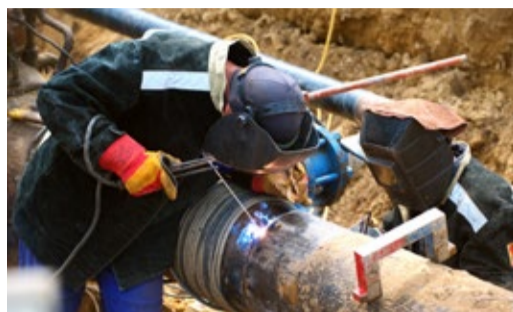
ОГНЕВЫЕ РАБОТЫ ПЕРЕД ВТД Ремонтные работы при подготовке к диагностическому обследованию Стр. 3
