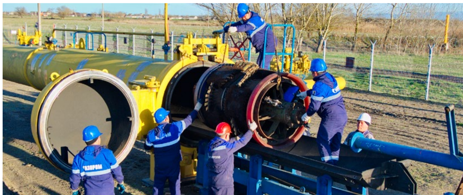
Запасовка дефектоскопа в камеру запуска
