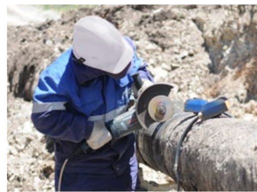
Подготовка к сварочным работам
