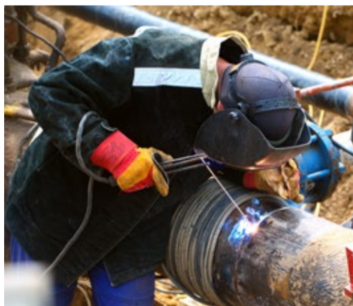
Сварочные работы на МГ «Каспийск – Ачису»
