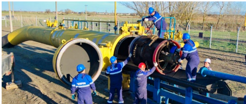
Подготовка дефектоскопа к запуску
