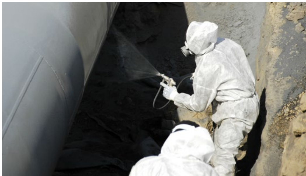
Наносится изоляционное покрытие
