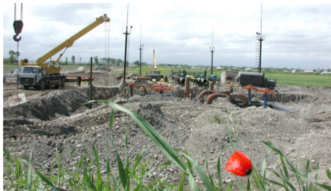
Строительство ГИС «Ново-Филя»
