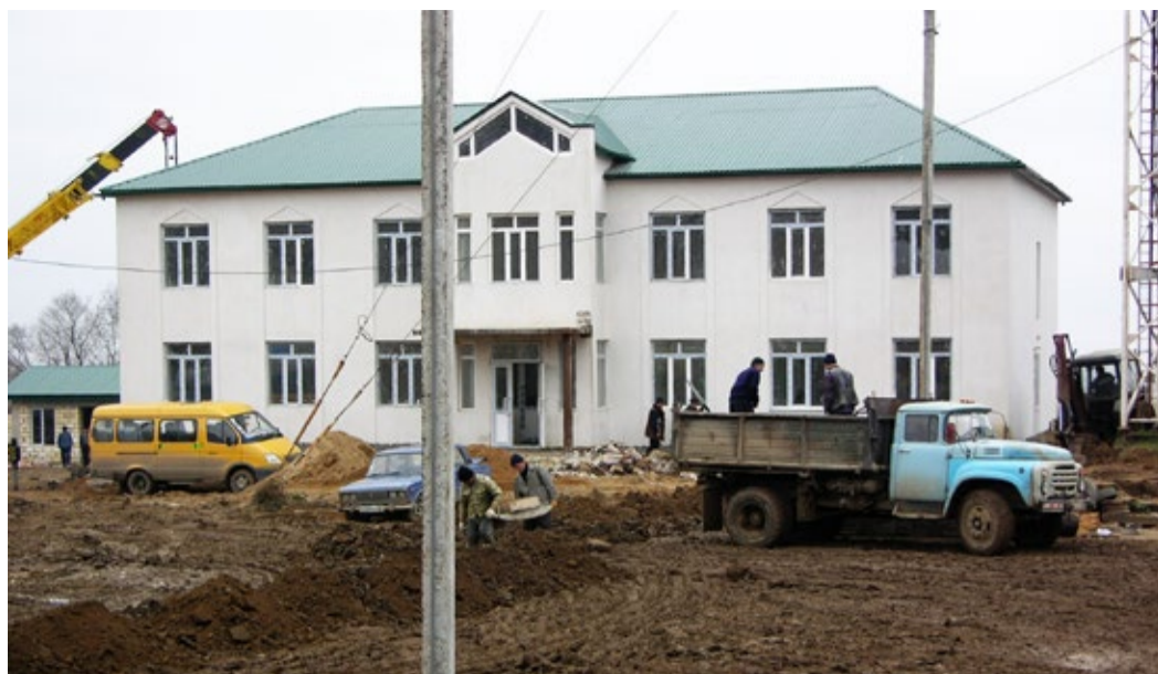
Строительство производственной базы Дербентского ЛПУМГ, 2004 год
