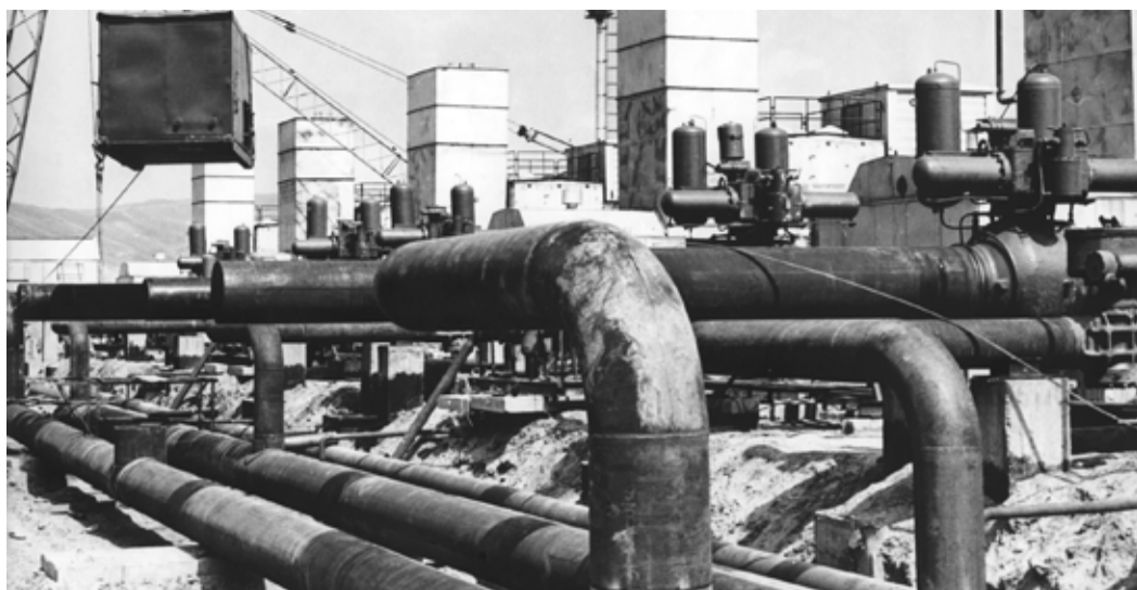
Строительство компрессорной станции «Избербаш»
