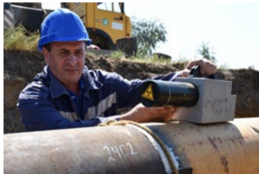
Рентгенографический контроль качества сварных стыков
