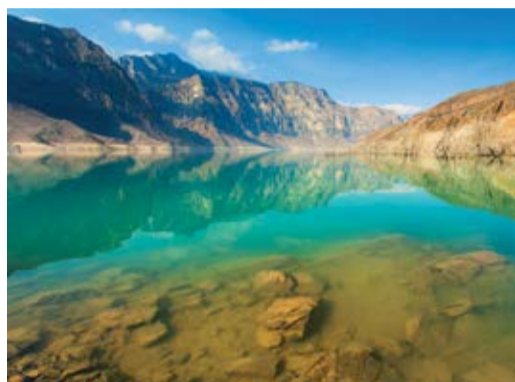
Водохранилище Ирганайской ГЭС
