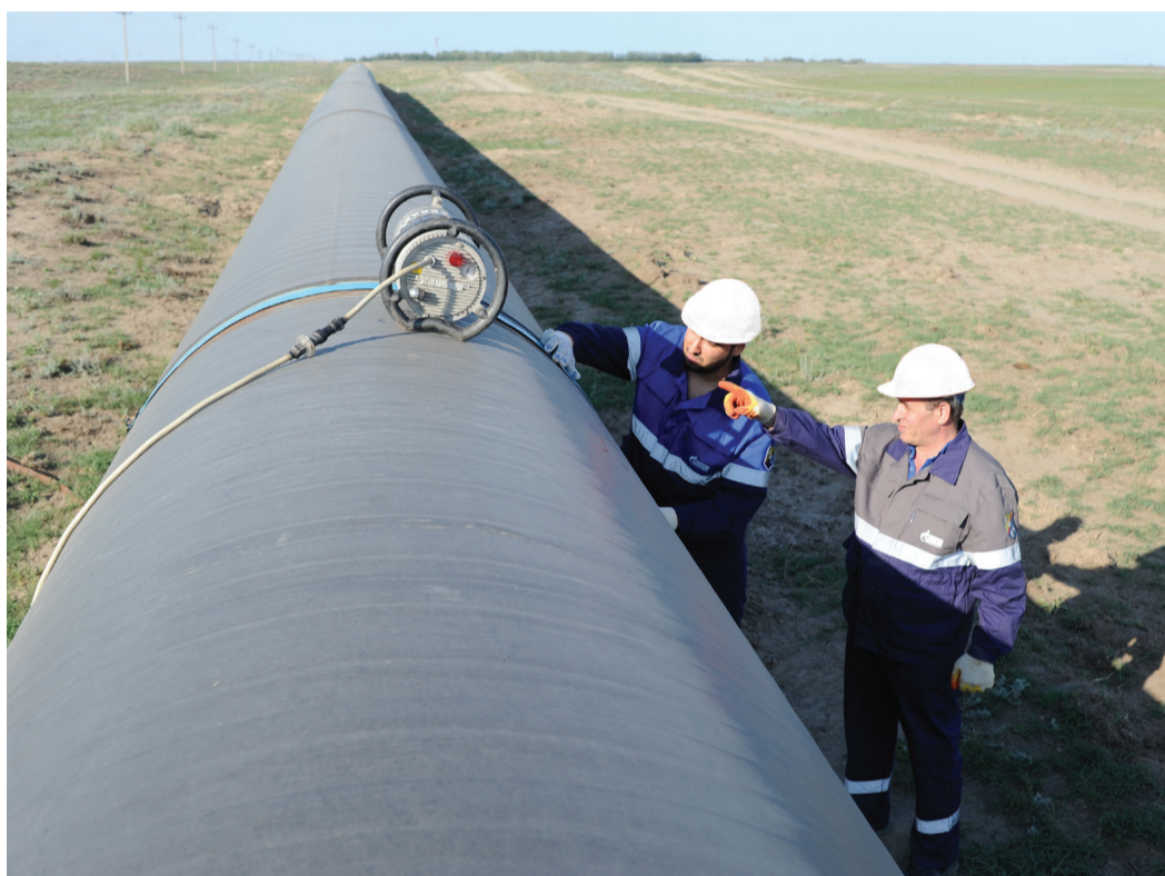
Подготовка сварного стыка к рентгенографическому контролю
