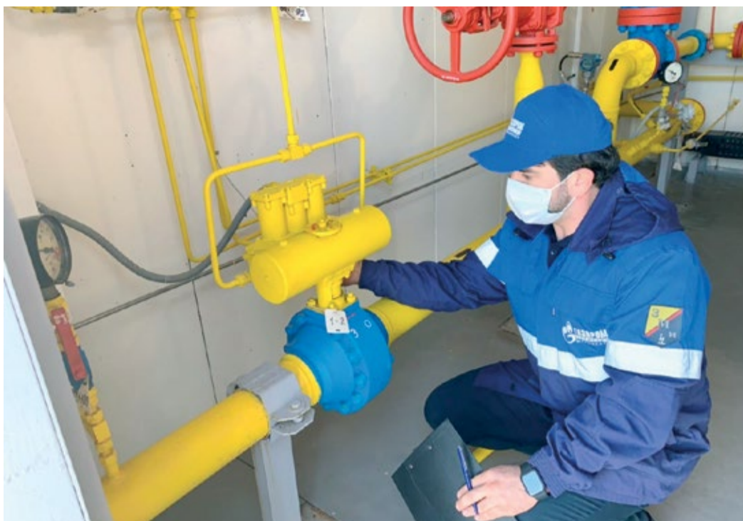
Перестановка входного крана ГРС «Ново-Филия»
