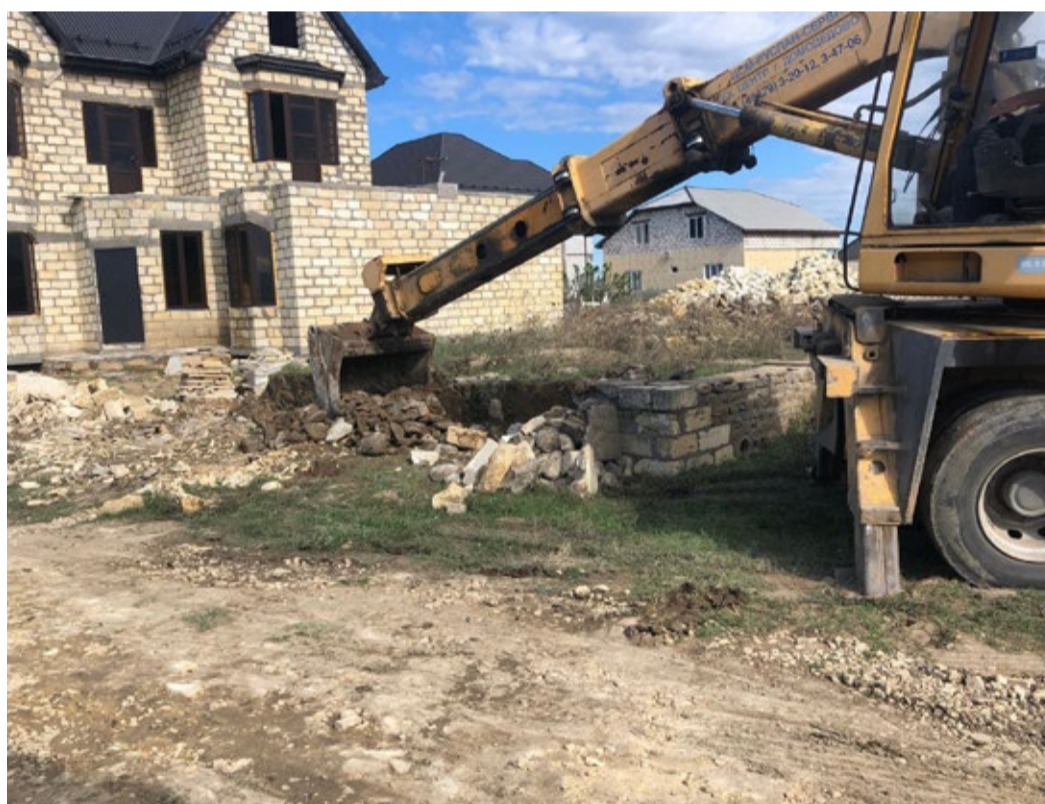
Снос фундаментов в охранных зонах
