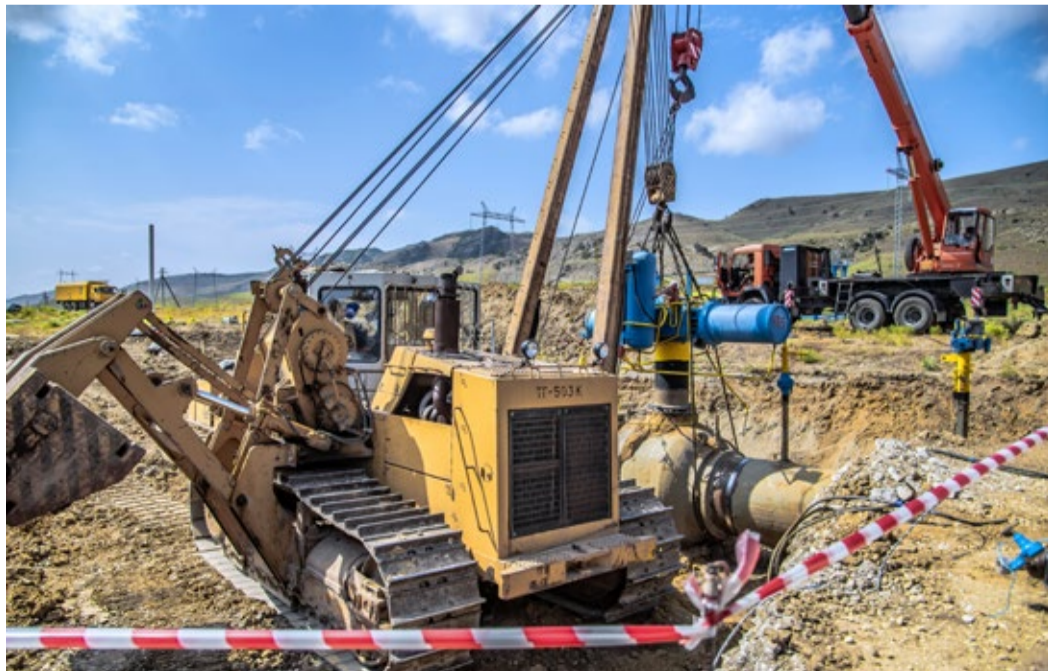
Огневые замена крана 565 585 Махачкала-Избербаи ЛПУМГ 2021-2462
