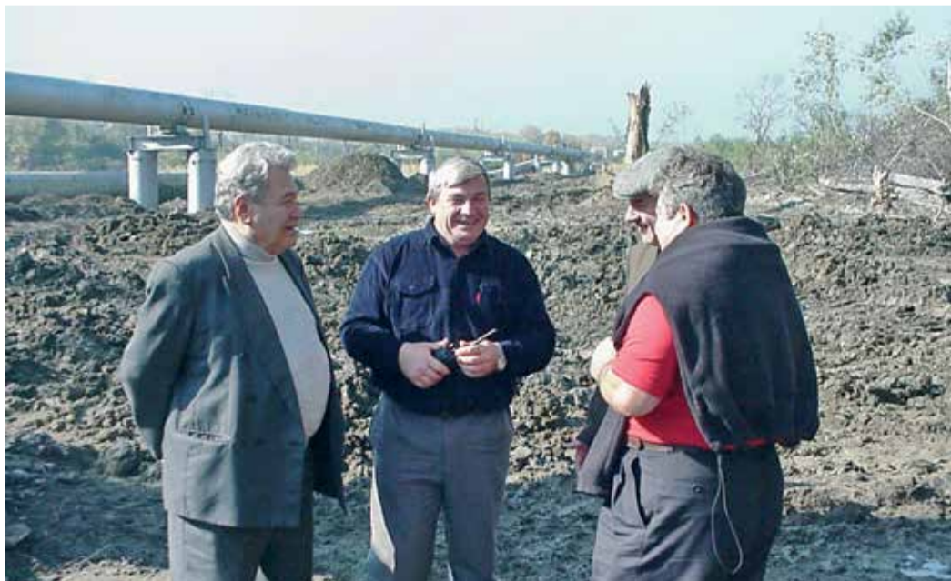
Александр Кабанец (посередине) с Михаилом Юсуфовым (слева) и коллегами на восстановлении воздушного перехода через р. Терек после теракта 2001 г.
