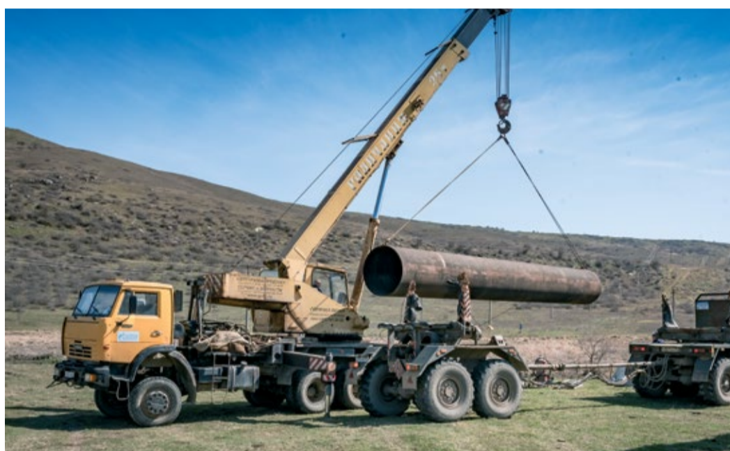
Доставка к месту аварии трубы DN 1200 для ликвидации последствий аварии
