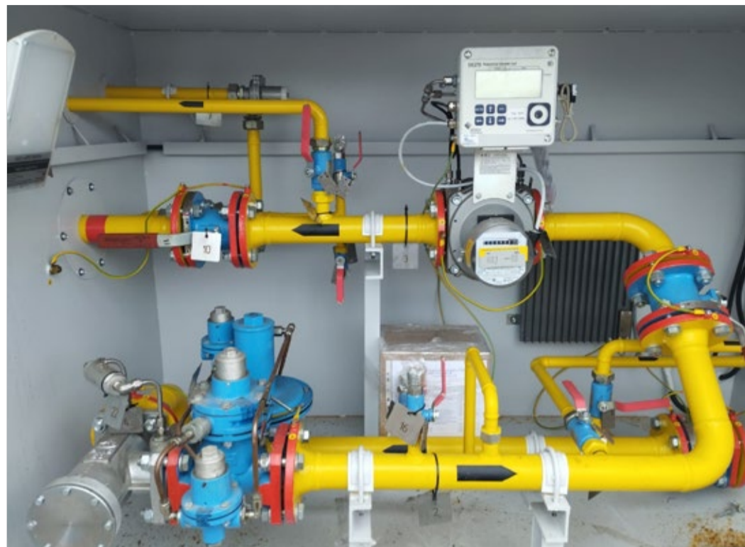
Рис. 2. Ротационный счетчик с корректором EK-270 GPC «Салик»
