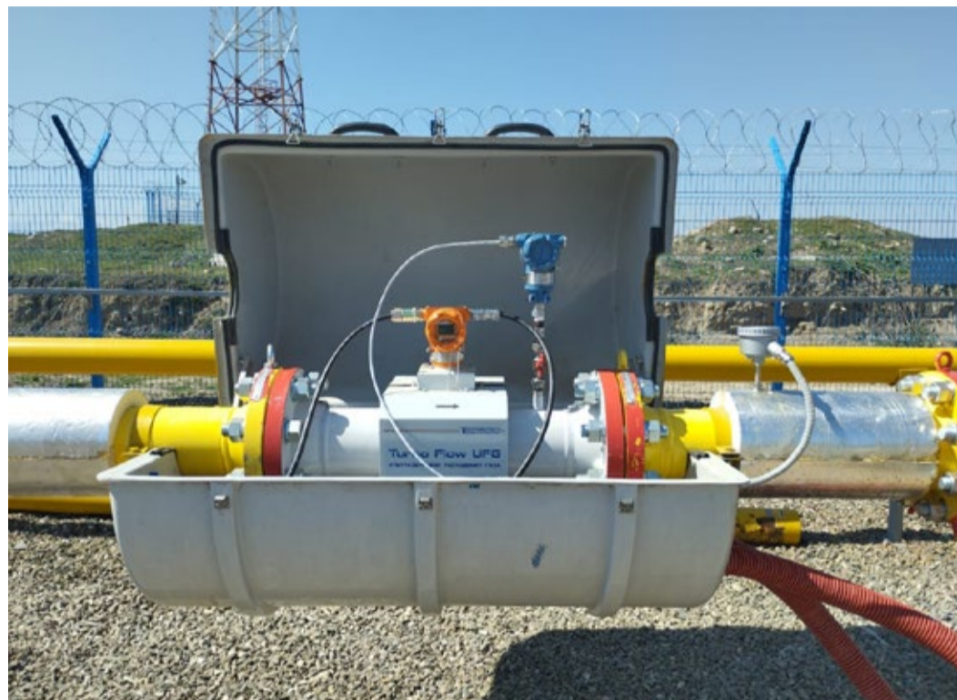
Рис. 1. Ультразвуковой расходомер TurboFlow UFG-F GPC «Касумкент»
