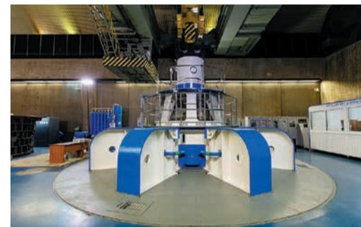
Монтаж гидроагрегата № 2 на Верхне-Тулумской ГЭС в рамках реконструкции
