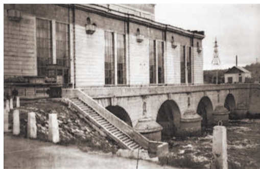
Архивное фото Нижне-Тулумской ГЭС
