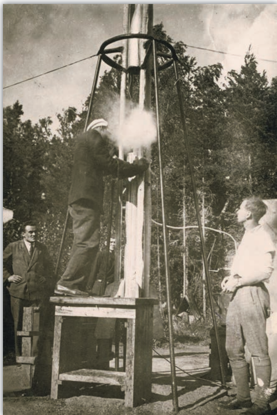
Ракета “09” перед стартом. Заливка кислорода в бак ракеты. Крайний слева С.П. Королёв. 17.08.1933. АРАН. Ф.1546. Оп.1. Д.75. Л.164.
