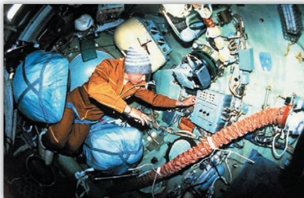
В.П. Савиных восстанавливает систему энергопитания «замерзшей» станции «Салют-7».
