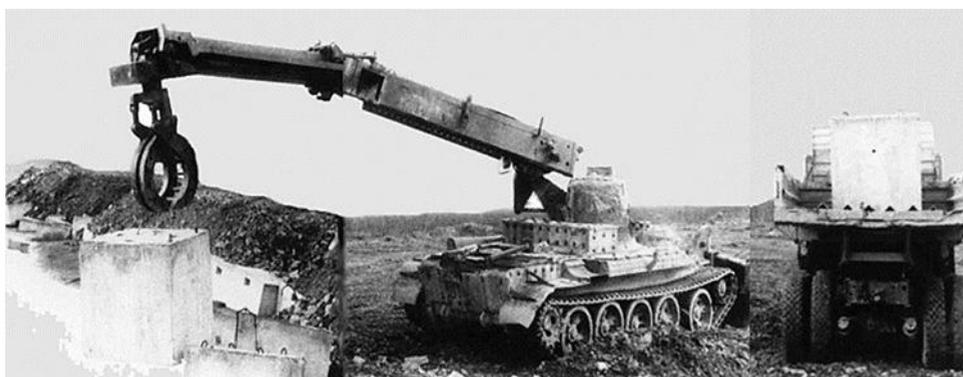
Рис. 5. Закрытие акватории оз. Карачай (промышленный водоем В-9) на ПО «Маяк» полыми железобетонными кубами с открытой нижней гранью ПБ-1 (разработка ПО «Маяк») с применением специальной техники
