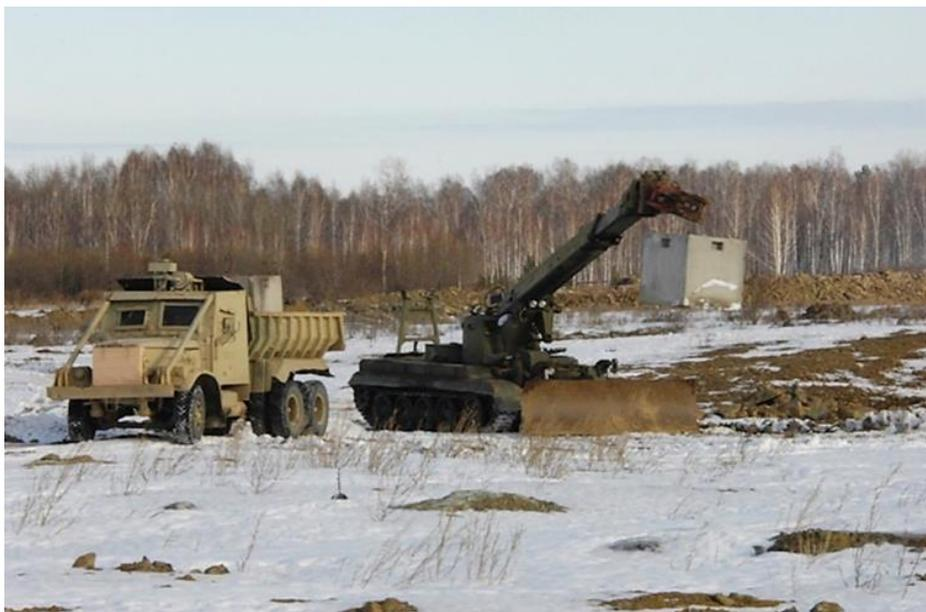
Рис. 7. Окончательная стадия закрытия акватории озера Карачай (промышленного водоема В-9) на ПО «Маяк» 25.11.2015 г. (фото А. Лёшкина)
