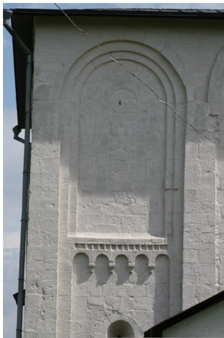
Илл. 8. Северное прясло западного фасада церкви Бориса и Глеба в Кидекше
