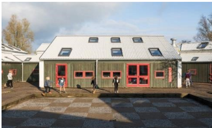
Рис. 1.169. Внешний вид сельской школы после ее модернизации (установка на крыше дополнительных окон) [1.423]
