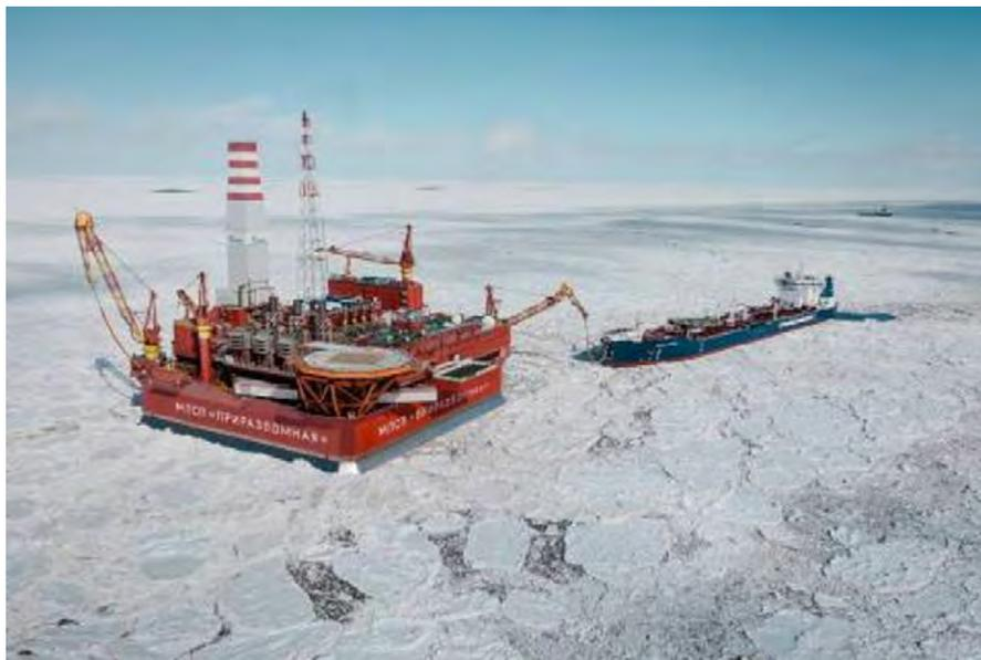
**Рис. 50.** Вид на МЛСП «Приразломная», в нижней части платформы виден основание-кессон
