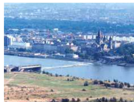
▲ Обрушившийся мост. 1976 г.
