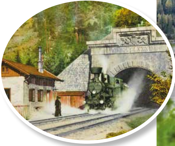
▲ Арльбергский железнодорожный тоннель у Лангена на открытке, выпущенной до 1916 года.
