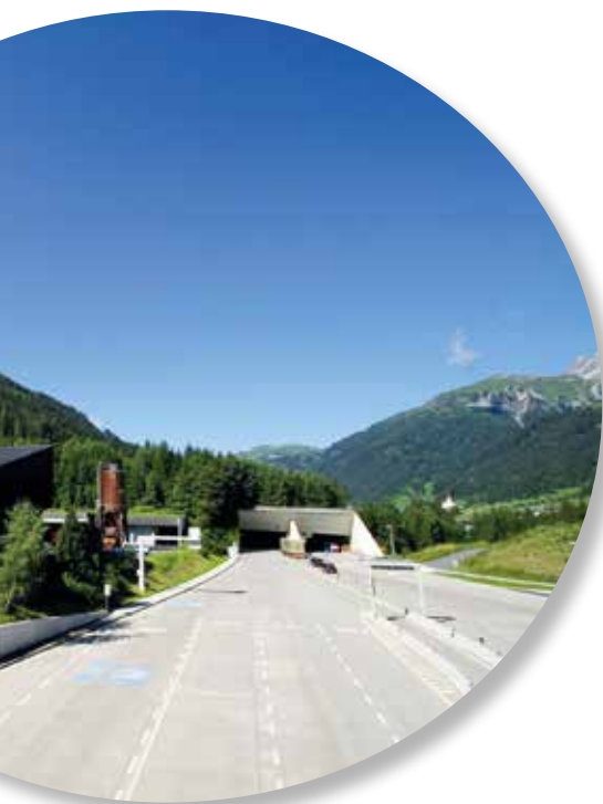
▲ Въезд в Арльбергский тоннель у городка Санкт-Якоб. Фото: © www.asfinag.at
