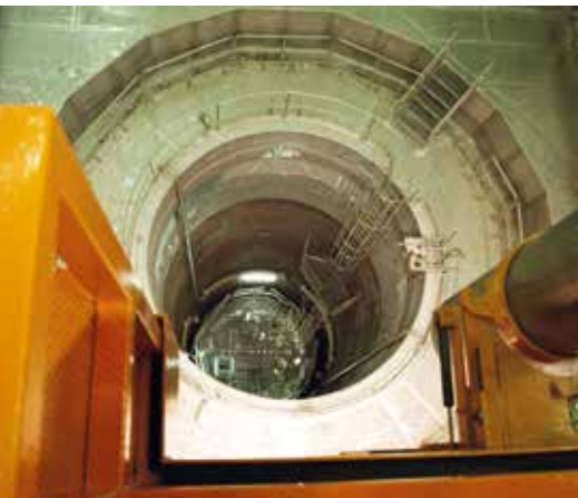
▼ Резервуар высокого давления
