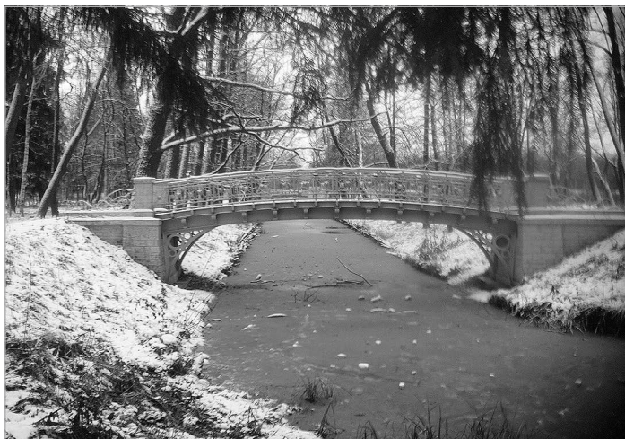
Архитектор Л. Ф. Шперер Металлический мостик на острове Любви 1880-е Фотография В. И. Ивановой. 2016
