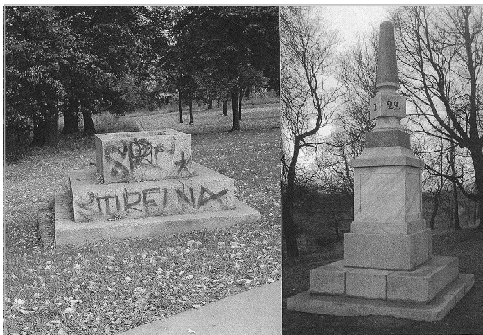
Верстовой столб «7/22» в поселке Стрельна, на 21-м км Санкт-Петербургского шоссе. До и после реставрации Фотография Е. А. Шишкиной. 2017
