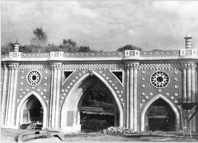
Реставрация Большого моста через овраг 1958–1961
