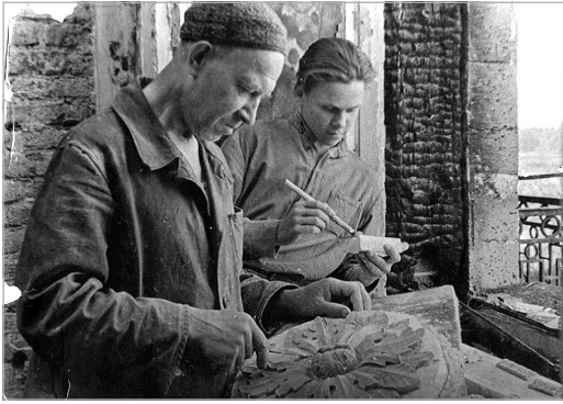
Мастер М. Е. Громов и ученик ремесленного училища закрепляют и расчищают лепку в Гатчинском дворце 1944 ГМЗ «Гатчина»
