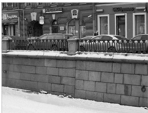
Петербург. Канал Грибоедова. Набережная после проведения ремонтных работ 2010-е
