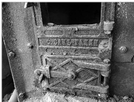
Калорифер, изготовленный на чугунолитейном и механическом заводе Ф. К. Сан-Галли Фотография В. В. Харламова. 2018
