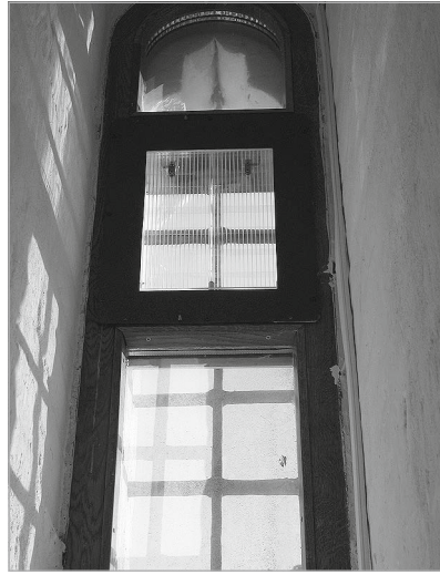
Использование АУ (в окнах первого яруса) для естественной вентиляции колокольни «Иван Великий» Московского Кремля
