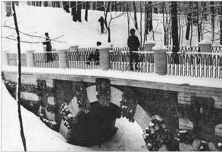
Гротесковый мост после реставрации 1958–1961
