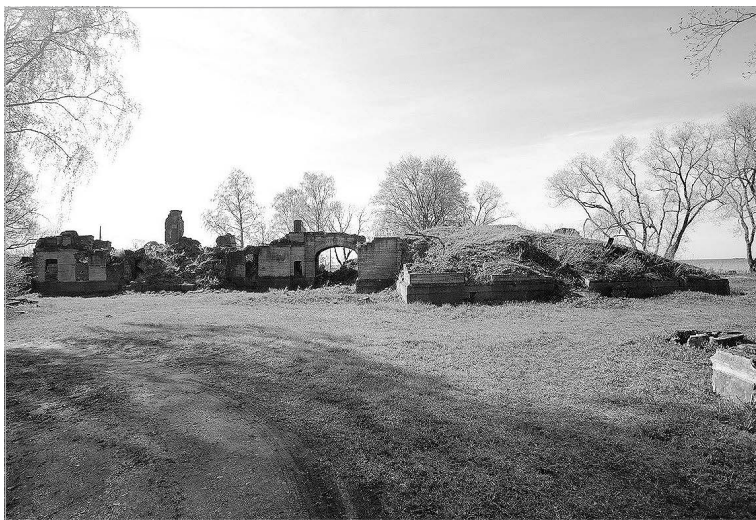
Нижняя дача. Руины Главного дома (Нижний дворец), восточный фасад Фотография В.С. Королева. 2016
