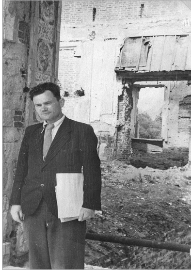
Архитектор Л. К. Абрамов в разрушенных залах Гатчинского дворца После 1947 ГМЗ «Гатчина»
