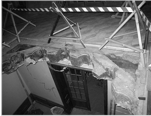
Сохранившаяся фигурная основа подъемного стола Фотография О. А. Холодной. 11 декабря 2017 ГМЗ «Петергоф»
