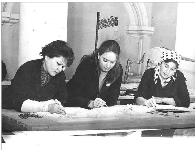
Аудиенц-зал в Большом дворце. Группа позолотчиц из звена Васильевой (Крюковой) за работой по прорезке рисунка в левкасе орнамента двери
