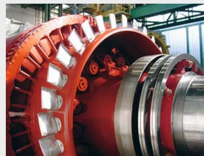
**ÖBB KRAFTWERKE.** Rotor eines Bahnstromgenerators im ÖBB Kraftwerk Braz
