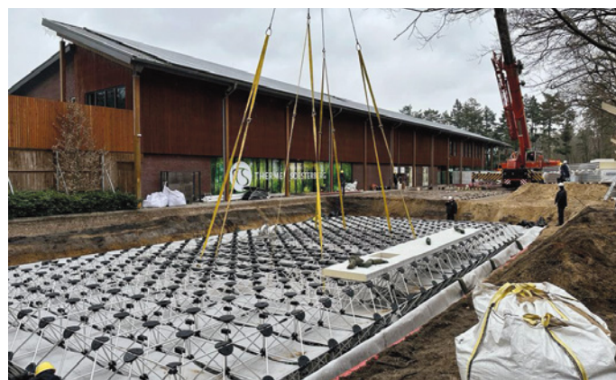
Die Therme Soesterberg wird ebenfalls klimaneutral betrieben. Hier wird der Pufferspeicher in den Boden eingelassen.
