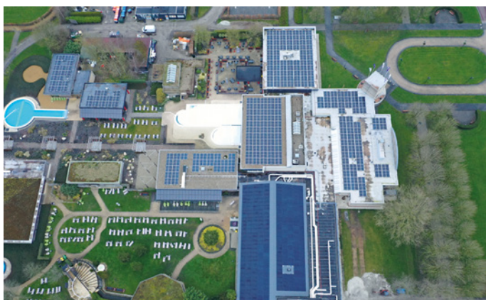
Die Therme Bad Nieuweschans (hier noch im Bau) ist eine von vier Anlagen im Thermenverbund der Familie Dolman.
