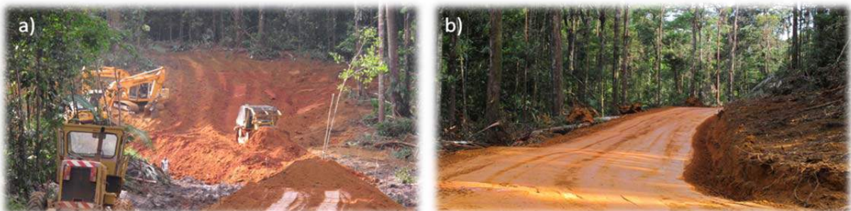
Figure 19: Aménagements engendrés par l'exploitation forestière : a) création d'un pont pour traverser une rivière; b) piste forestière nouvellement créée.
