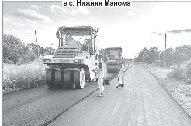
Укладка нового асфальта в с. Нижняя Манома
