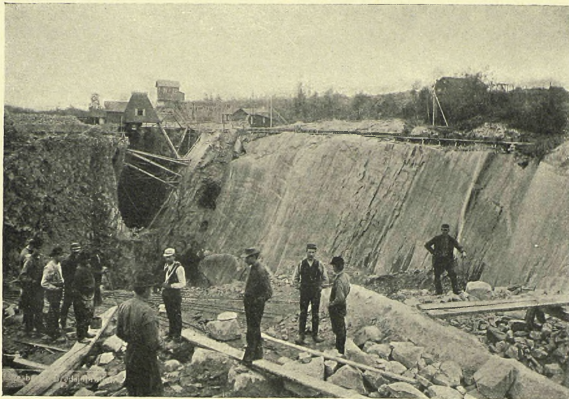
Рис. 2. Открытая разработка мощного круто падающего пласта желѣзной руды.
