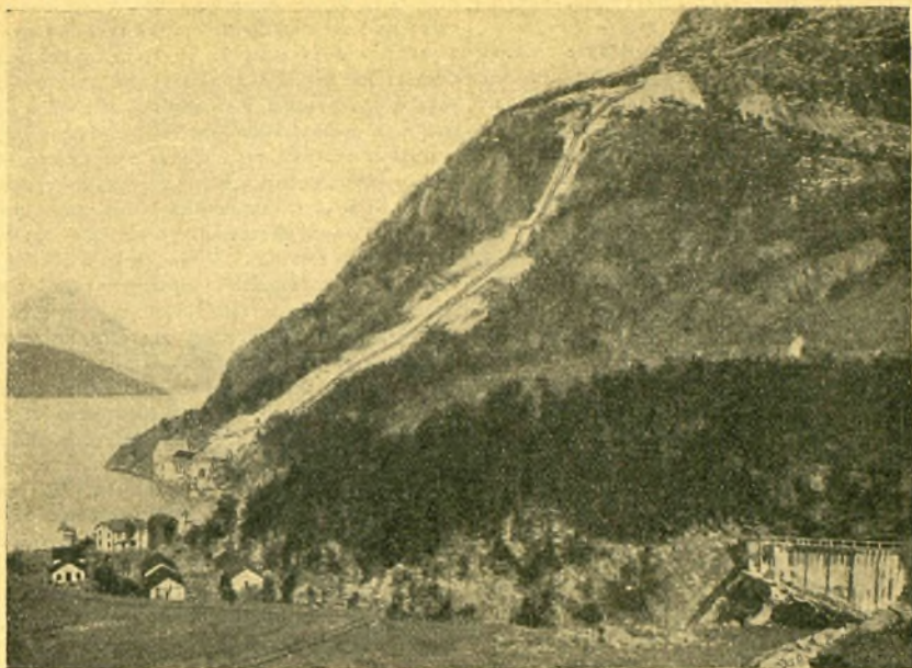
Рис. 86. Трубопроводъ и станція на р. Тиссъ близъ Одды.
