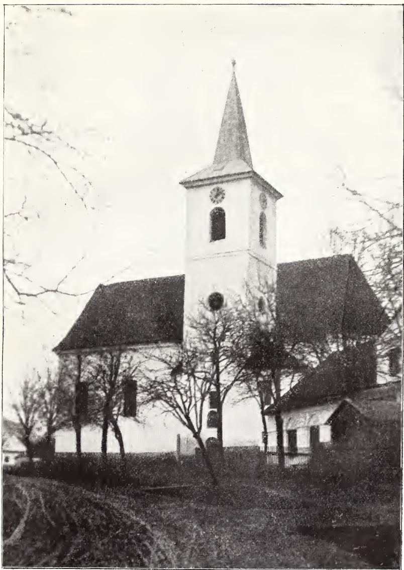
Obr. 51. Farní kostel ve Vranové Lhotě.
