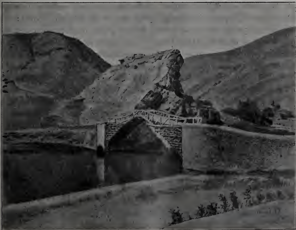
Brücke über den Muzur, zwischen Peri und Pertag (zu S. 174).
