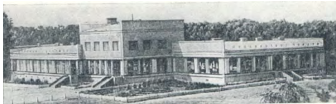
Торговельний центр у Жовтневому, 1972 р.
