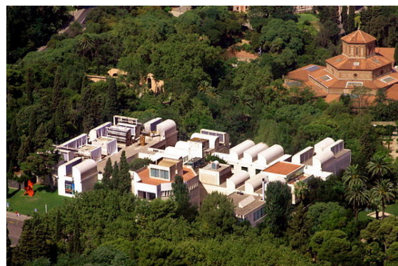
Vista aèria de l'edifici de Josep Lluís Sert, seu de la Fundació
