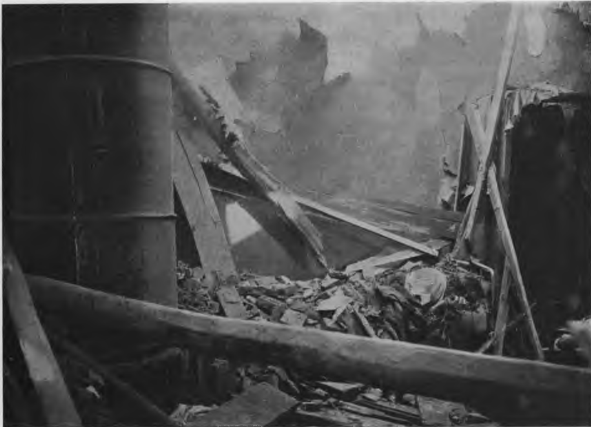
Убитый при разрушеніи дома 11-дюймовымъ снарядомъ изъ гаубицы.
