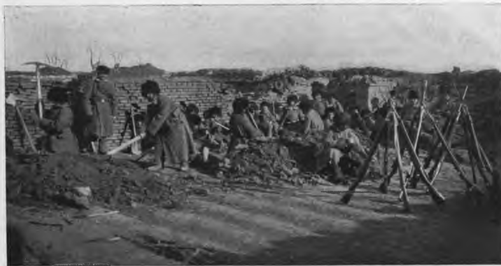
Работы по укрѣпленію.
