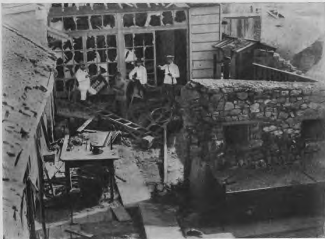
Разрушеніе отъ огня.
