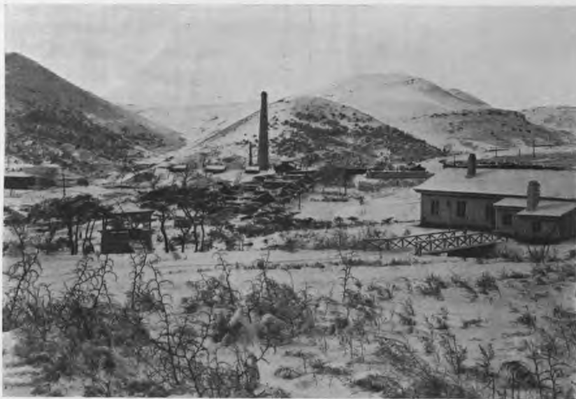
Разрушенная китайская деревушка.
