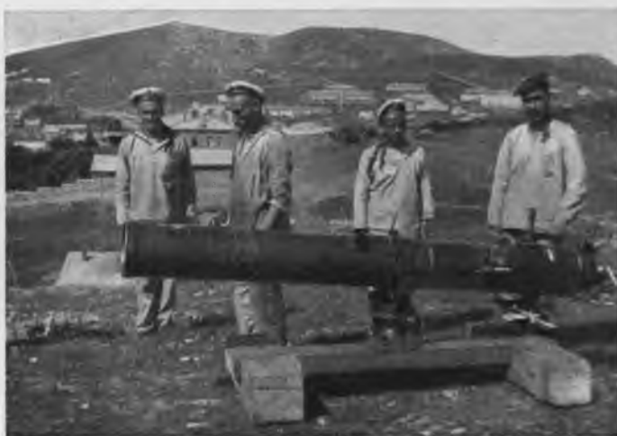
Минный аппаратъ для стрѣльбы на сушѣ.
