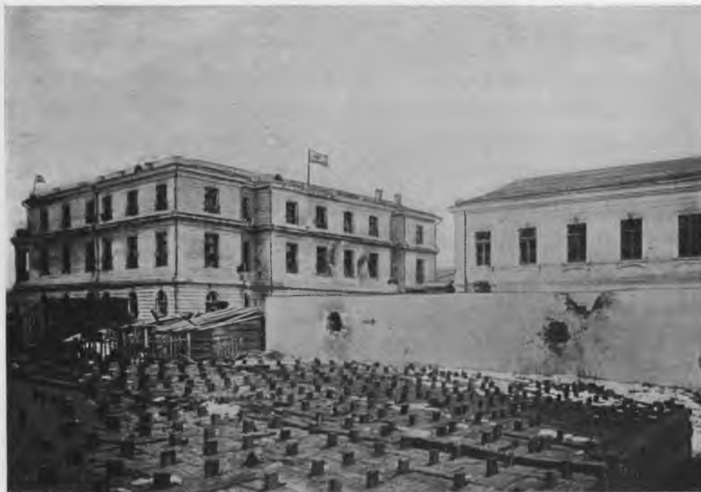
Поврежденія въ госпиталѣ.
