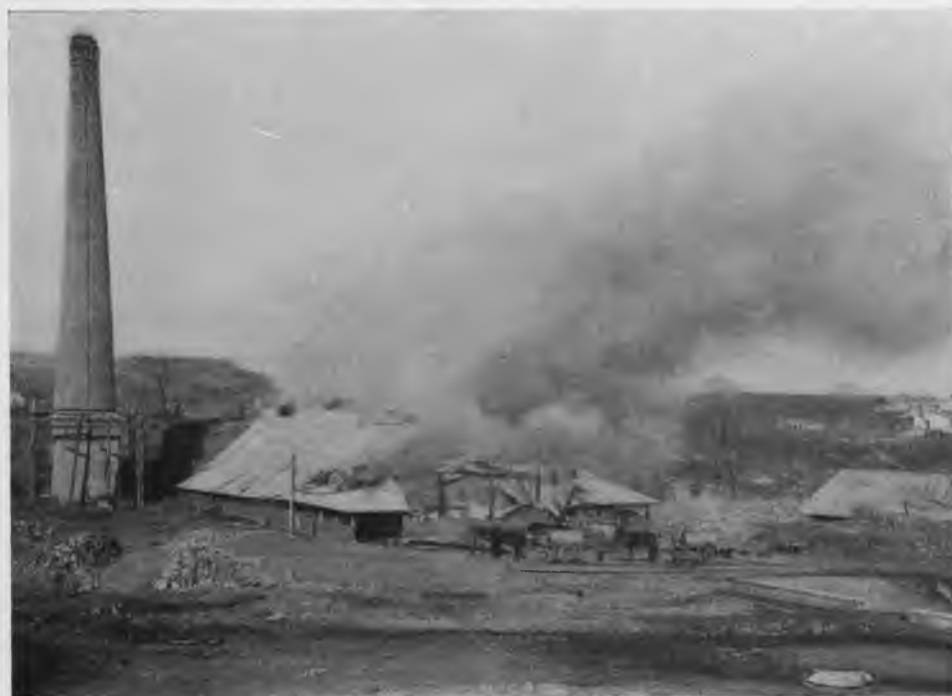
Пожаръ на заводѣ Суворова.
