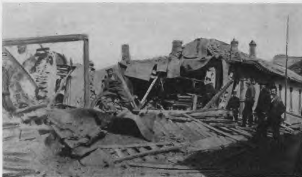
Разрушенная типографія „Новый Край“.
