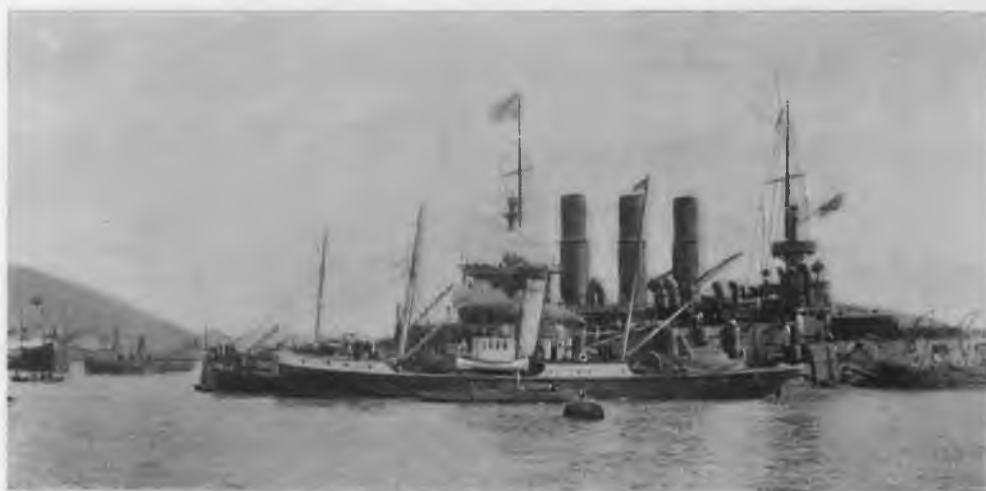
Постановка кессона на „Ретвизанъ“ въ Портъ-Артурѣ.
