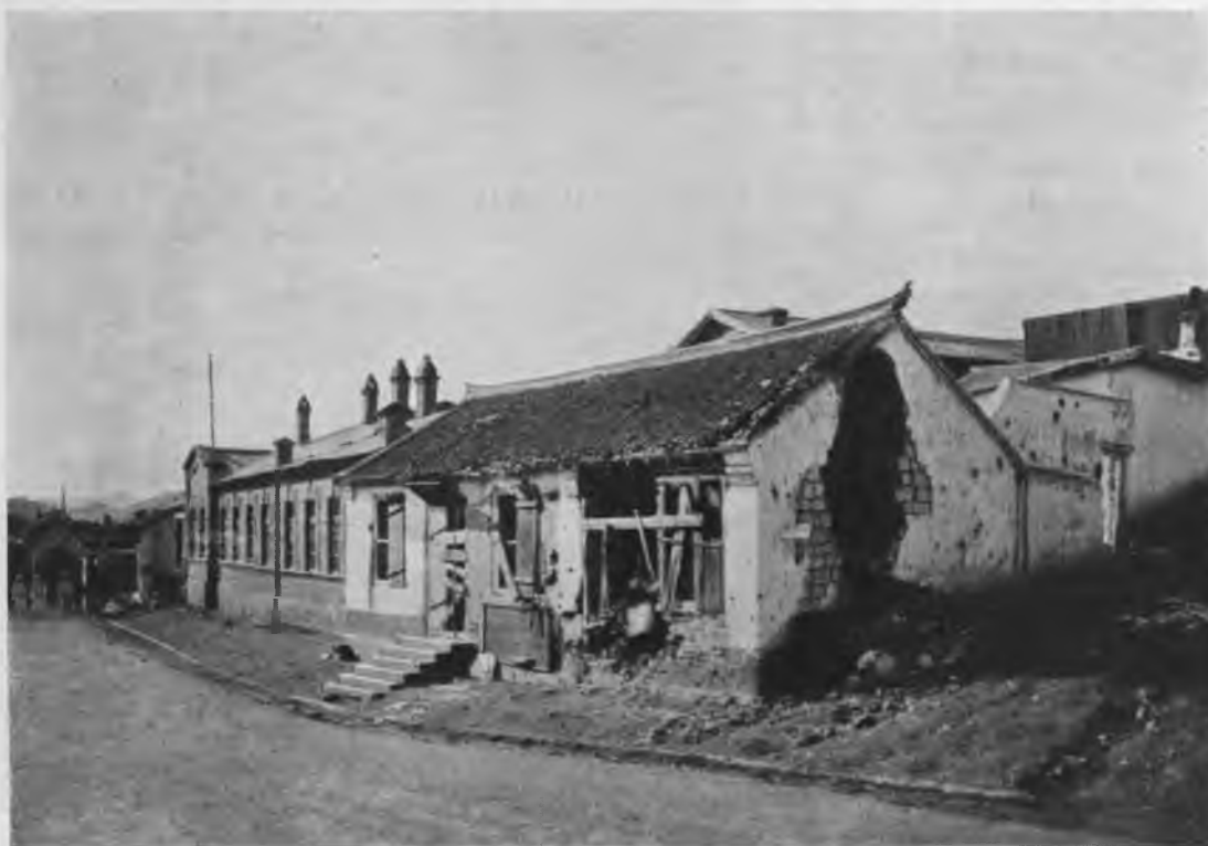
Разрушеніе отъ бомбардировки.
