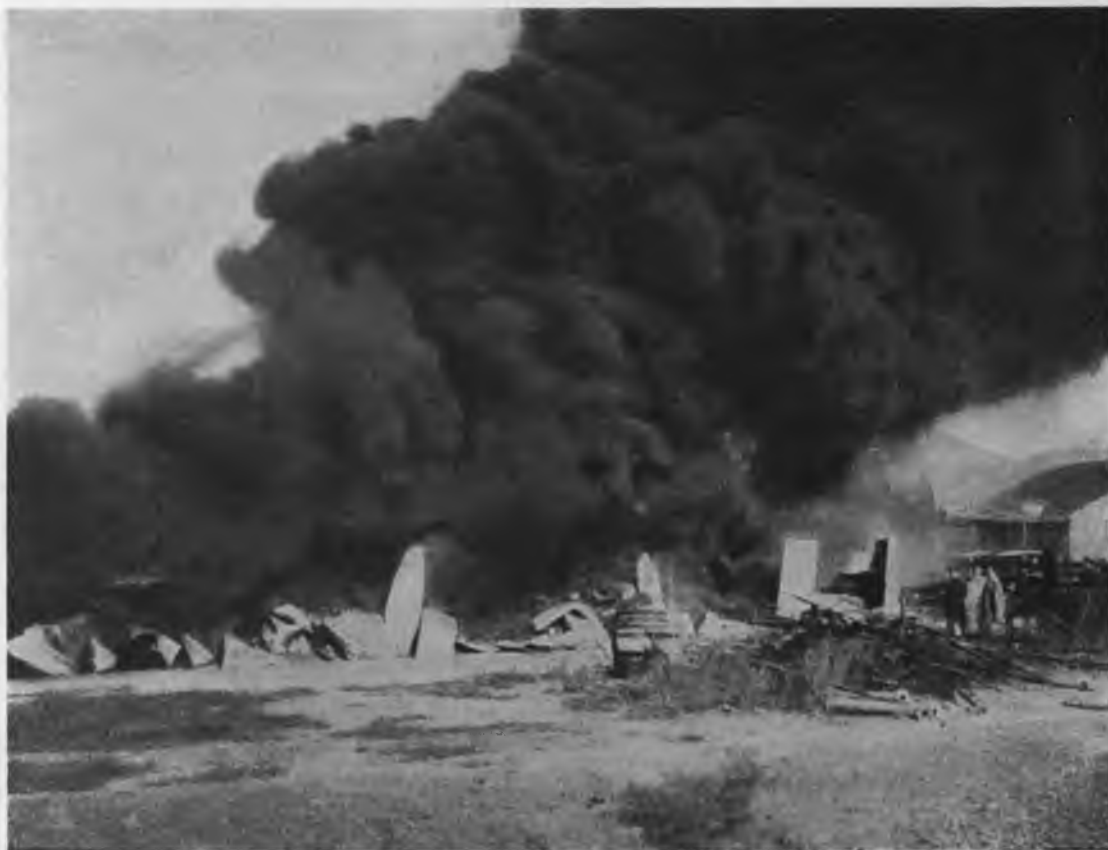
Пожаръ Инженерныхъ складовъ въ Портъ-Артурѣ.
