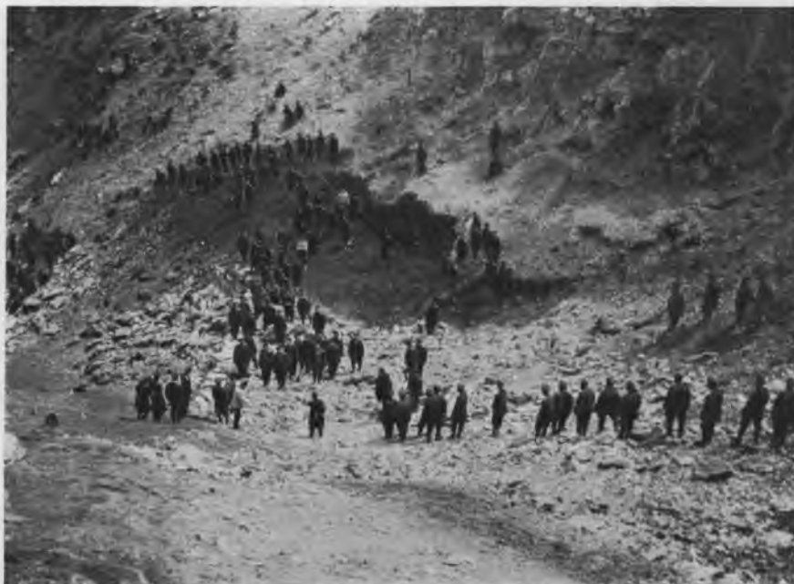
Работы по укрѣпленію Ляотешаня.
