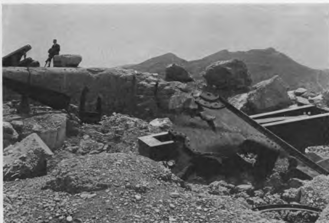
Разрушеніе на батарее.
