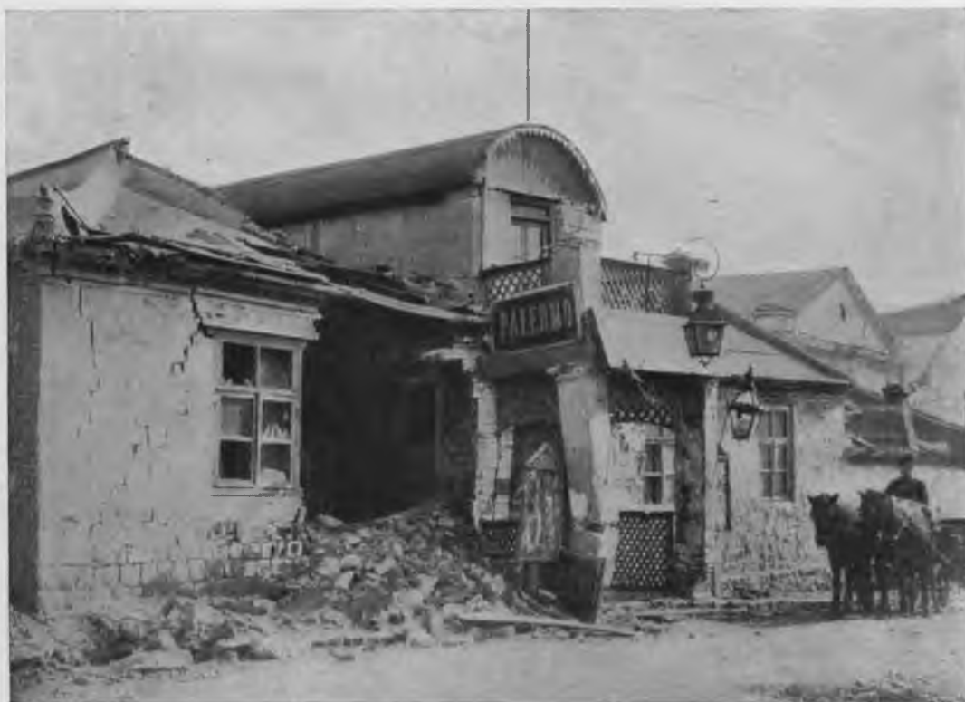
Разрушенія отъ бомбардировки.
