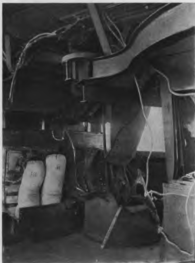
Поврежденіе у фокъ-мачты.
