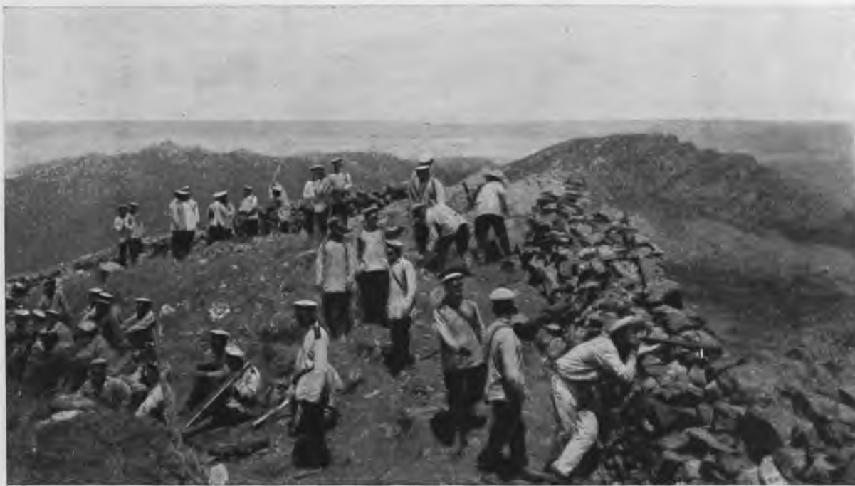
Постройка траншеи на Юпилазѣ.
