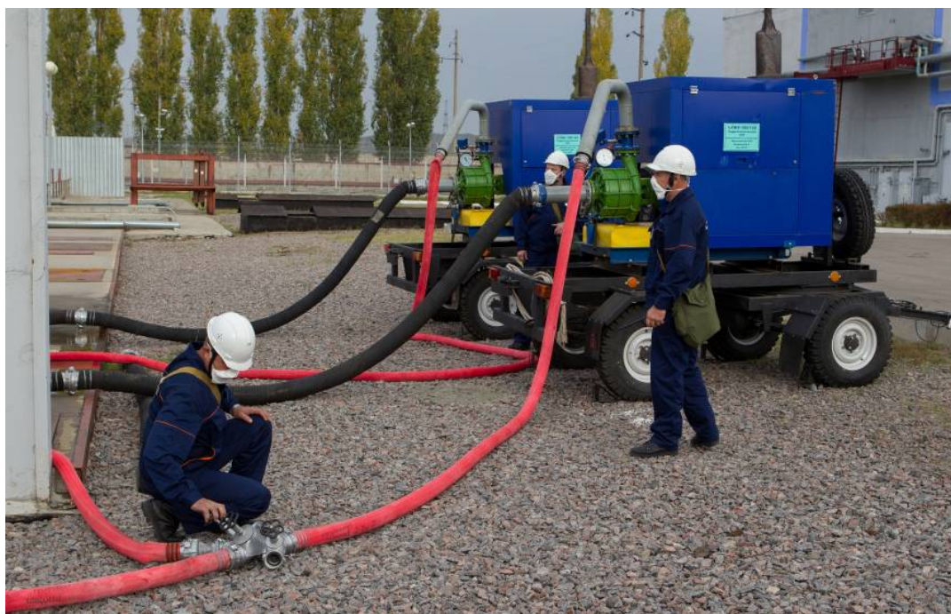
Рисунок 16.4. Комплексные противоаварийные учения на Ленинградской АЭС (2015 г.). Отработка подключения передвижной насосной установки
