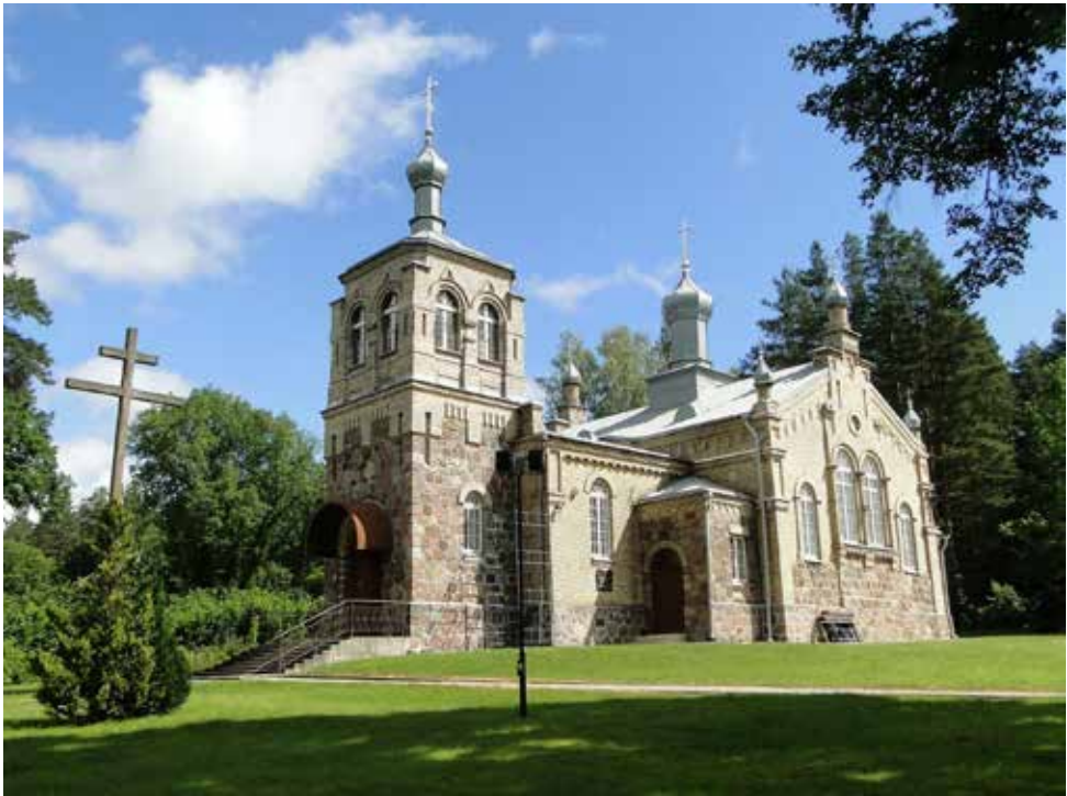
12. Cerkiew prawosławna w Królowym Moście. W 1913 rozpoczęto budowę a w 1915 zakończono zadaszanie. Wnętrza wykonano w okresie międzywojennym.
