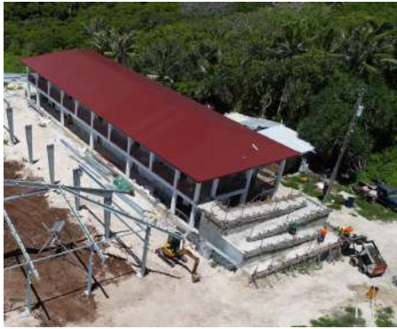
A. P. Lutali ES Classrooms
