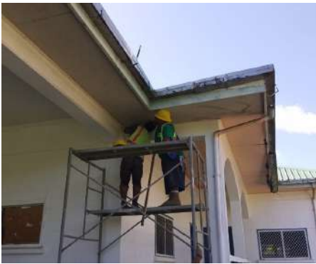
Ta'u DPS Substation Repair
