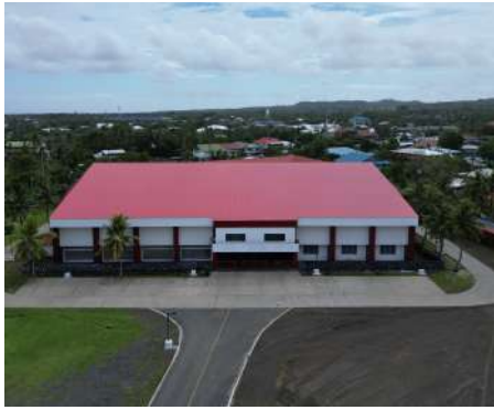
Kanana Fou Taeafua O Tupulaga Multipurpose Facility
