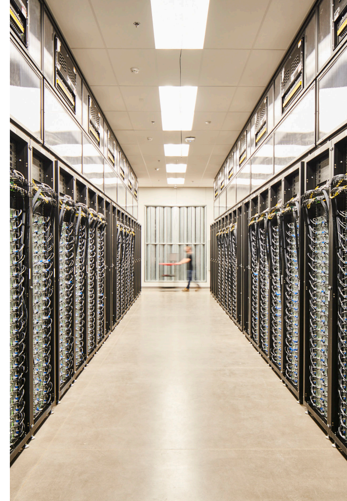
Apple'ın 2012'de açılan Reno veri merkezi, sunucularını mümkün olduğunca dışarıdaki havayla soğutarak ılıman iklimden yararlanıyor.
