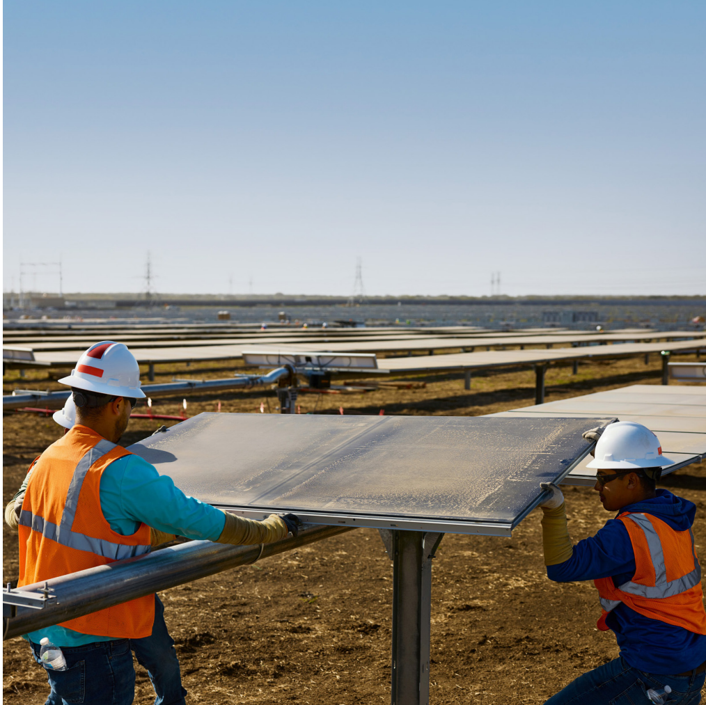
Apple, müşterilerin Apple aygıtlarını şarj etmek için kullandıkları elektriği ele almaya yardımcı olmak amacıyla Teksas, Brown County'deki bu büyük ölçekli güneş enerjisi projesi de dahil olmak üzere dünya çapında yenilenebilir enerjiye yatırım yapıyor.
