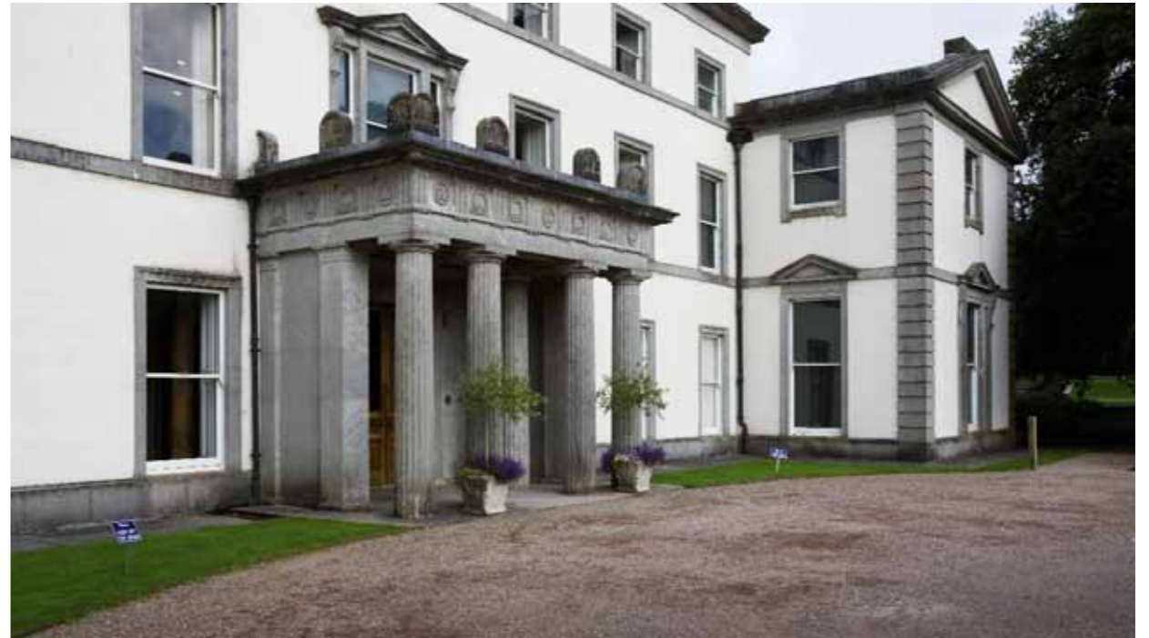
(fig. 171) PORTICO, FOTA HOUSE
