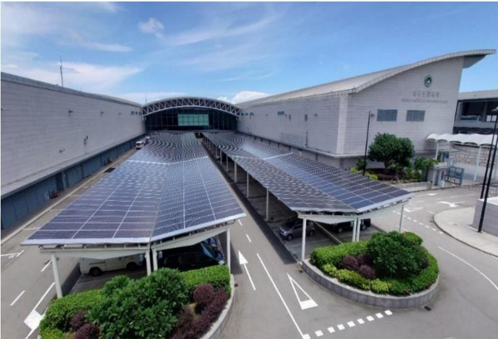
圖7 北安碼頭停車場光伏發電系統
