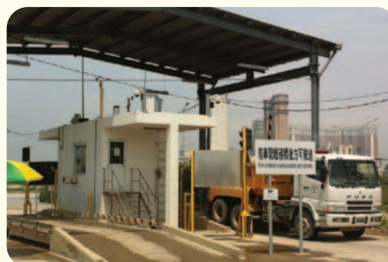
Bâsculas no Aterro para Resíduos de Materiais de Construção
