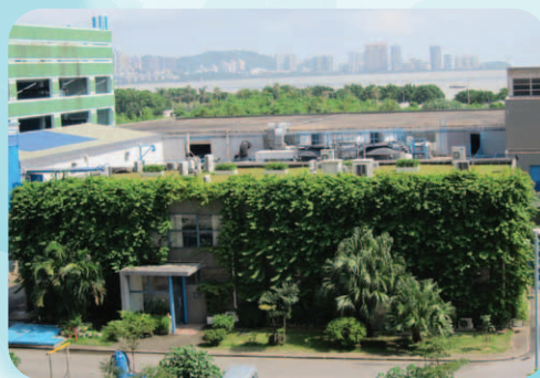
澳門半島污水處理廠行政樓天台綠化景觀
