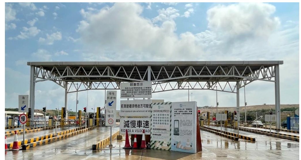
Aterro para resíduos de materiais de construção
