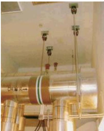
(Foto 10.3) Isoladores de vibração são instalados na casa das máquinas.
