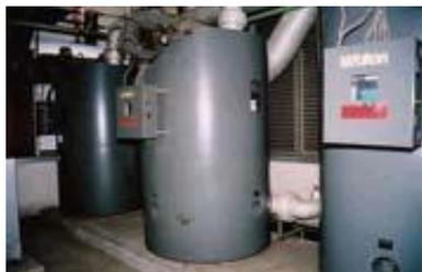
(Foto 3.7) Melhorar a eficiência das caldeiras ajustando o rácio ar/combustível e proceder a uma manutenção regular.
