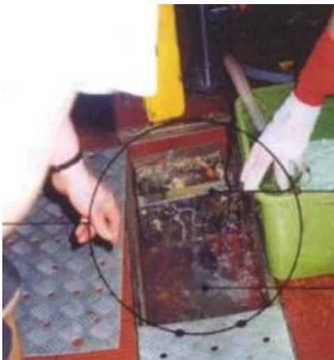
(Foto 5.5) Instalar grelhas separadoras em frente aos filtros de gordura de forma a separar as partículas grossas das partículas finas.
