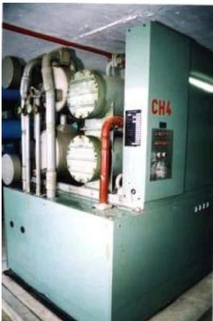
(Foto 7.7) Recuperação de calor do sistema de ar condicionado central.
