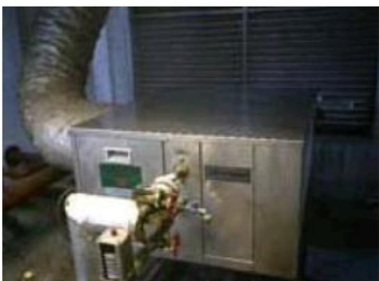
(Foto 7.9) Uma bomba de calor reutiliza o calor desperdiçado, recupera a energia perdida para um pré-aquecimento da água.
