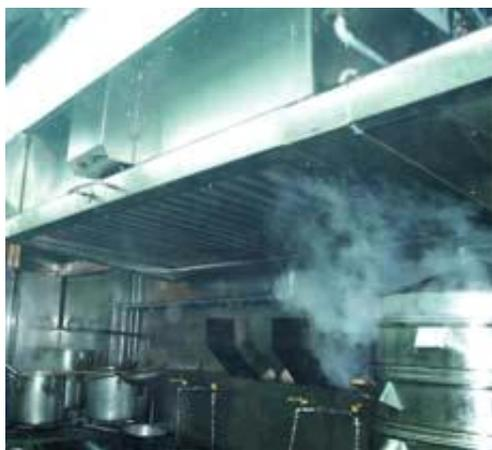
(Foto 3.9) Os precipitadores electrostáticos podem ser instalados sobre os fogões, sendo desnecessária a instalação fora do restaurante.
