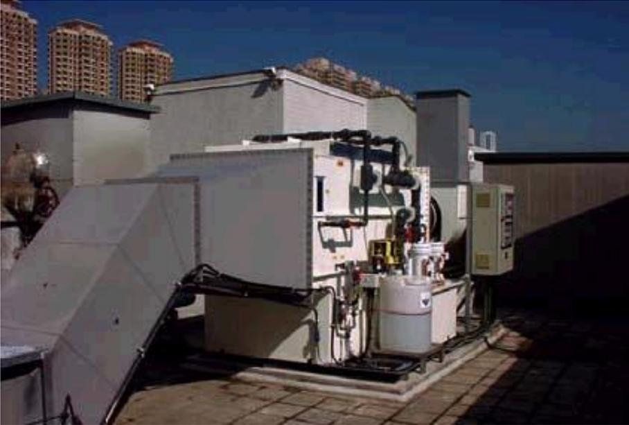
(Foto 3.11) O equipamento ilustrado na fotografia (packed scrubber) possui uma menor eficiência e requer mais espaço, comparativamente com um precipitador electrostático.
