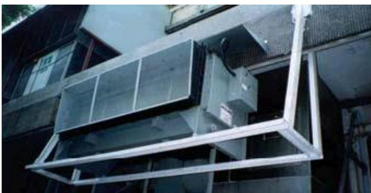
(Foto 3.4) Os precipitadores electrostáticos equipados com um sistema de auto-limpeza são o tipo de equipamento preferencial de controlo de óleos e fumos.
