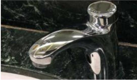
(Foto 5.3) As torneiras controladas por sensores abrem-se e fecham-se, automaticamente, aquando da presença das mãos.
