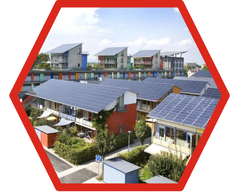
Optimierung vom Microgrid bis zur Haushaltsanlagen
