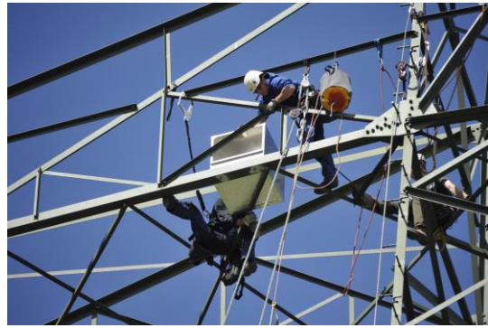
Abbildung B.2 Montage eines Brutkastens
