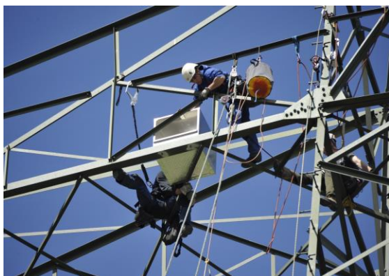
Abbildung 2-4: Montage eines Brutkastens
